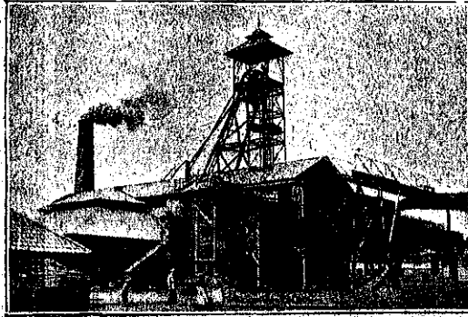
PUITS D'EXTRACTION D'UNE MINE. (VUE DU DEHORS)
